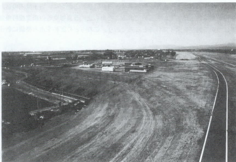
写真-2 公園との一体整備によるスーパー堤防（利根川羽生市常木地区）
