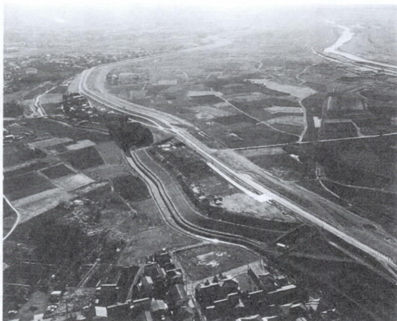
写真-1 水防拠点等と合わせて整備中のスーパー堤防 (熊谷市久下地区、カスリーン台風時決壊地点)
