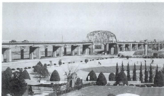
初代治水橋の全景
