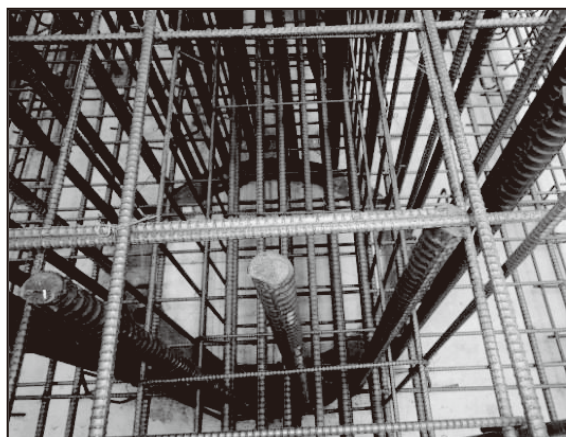
杭頭補強筋と上部構造鉄筋の状況 (鉄筋との干渉なし)
