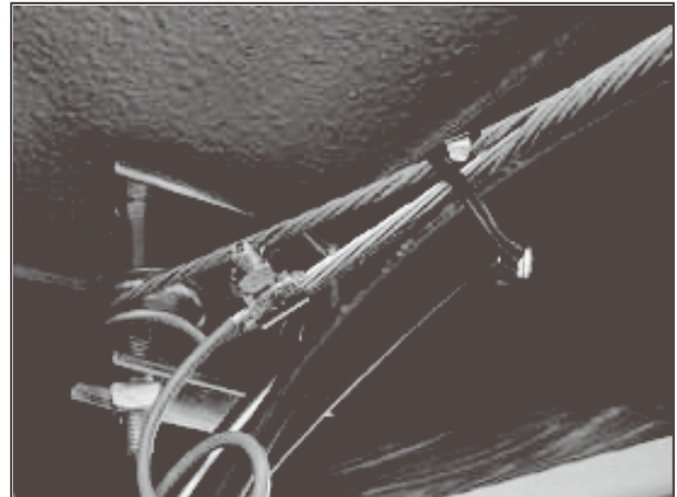
② ちょう架用線への接地状況
