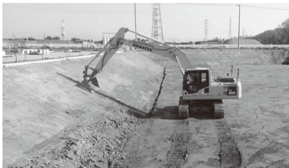
写真 2 マシンガイダンスショベルによる法面整形状況（左）、操縦席のモニター画面（右）
