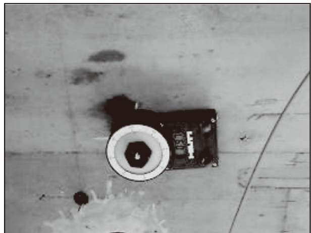
② 既存インサートの強度確認状況
