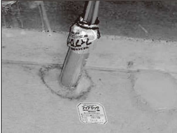
① 区画貫通部の措置状況
