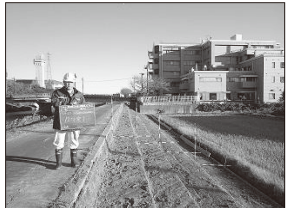
②法面の段切り
