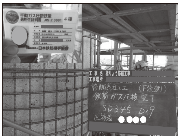
③現場でガス圧接技量的確性証明書の確認
