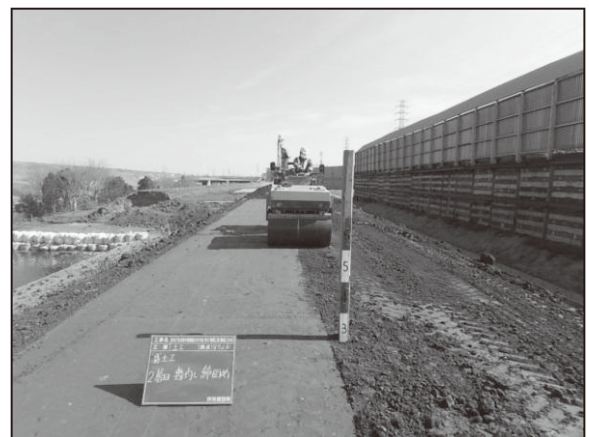
③締固め（各層確認）
