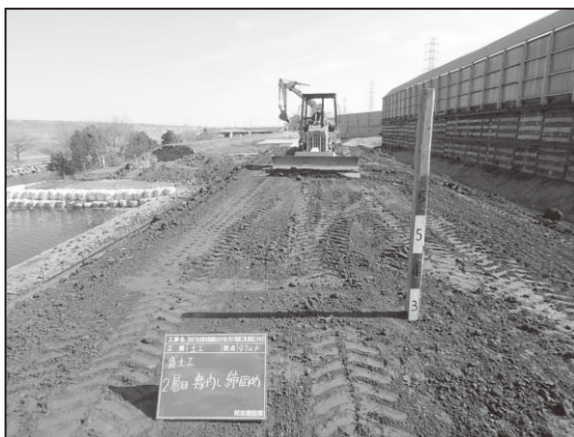
③巻出し・敷き均し（各層確認）
