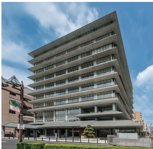
▲草加市役所新庁舎(南側より)
