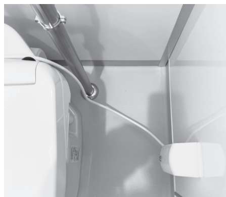
右側壁にコンセントを施工した例
