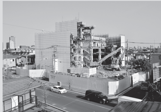
旧庁舎解体状況(躯体)
