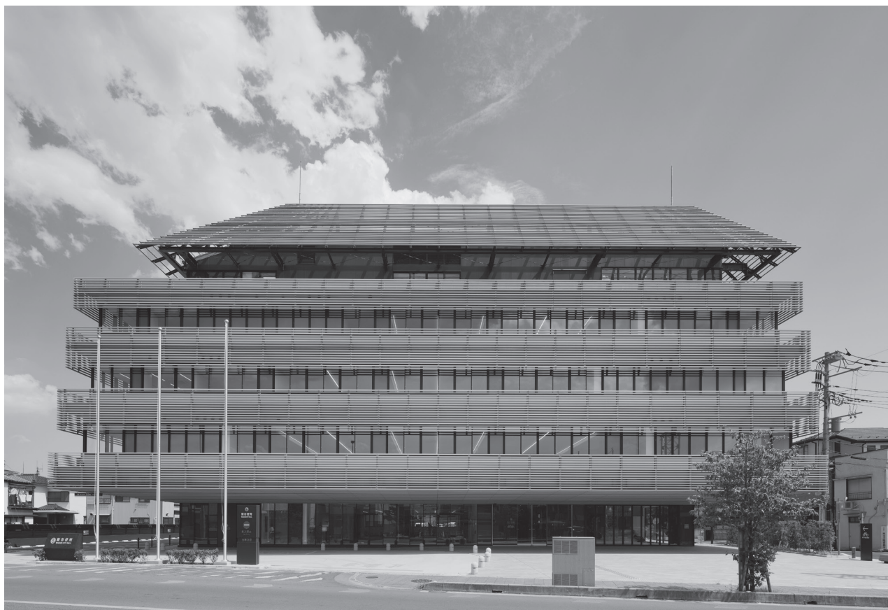
新庁舎北面（県道側）
