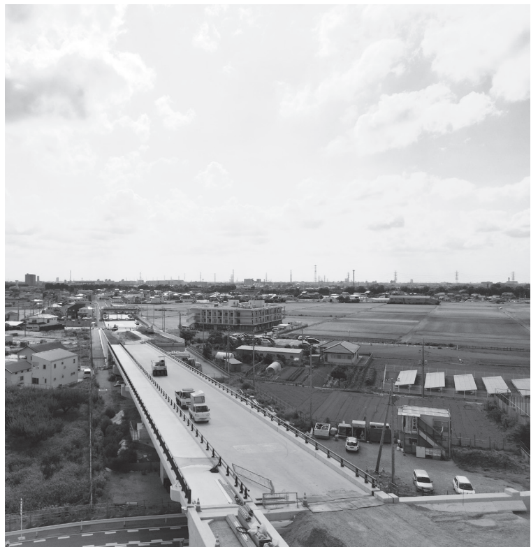
埼玉側取付橋全景
