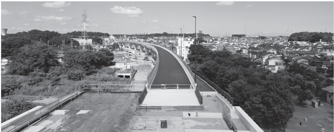
千葉側取付橋全景
