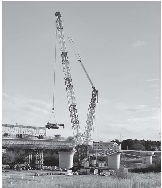
650t クレーンによる作業状況
