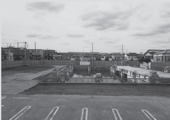
旧庁舎解体完了
