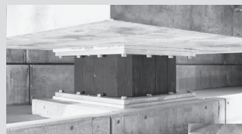
◀鉛プラグ挿入型積層ゴム支承
