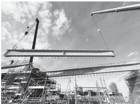
クレーン共振り作業による桁架設
