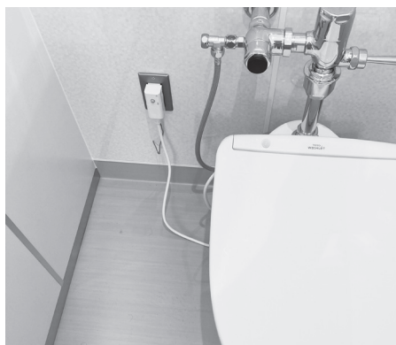
正面壁の左側にコンセントを施工した例
