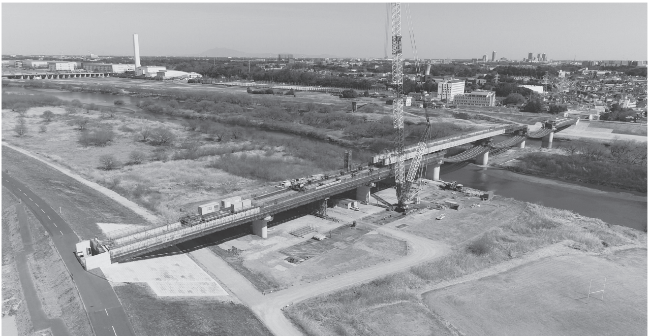
送出し架設状況
