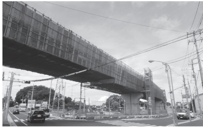
現道上への桁架設
