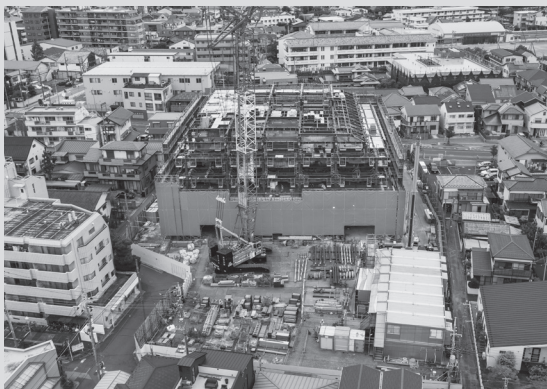
新庁舎建設状況(鉄骨建方)
