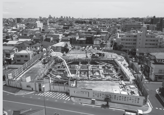
新庁舎建設状況(基礎工事)
