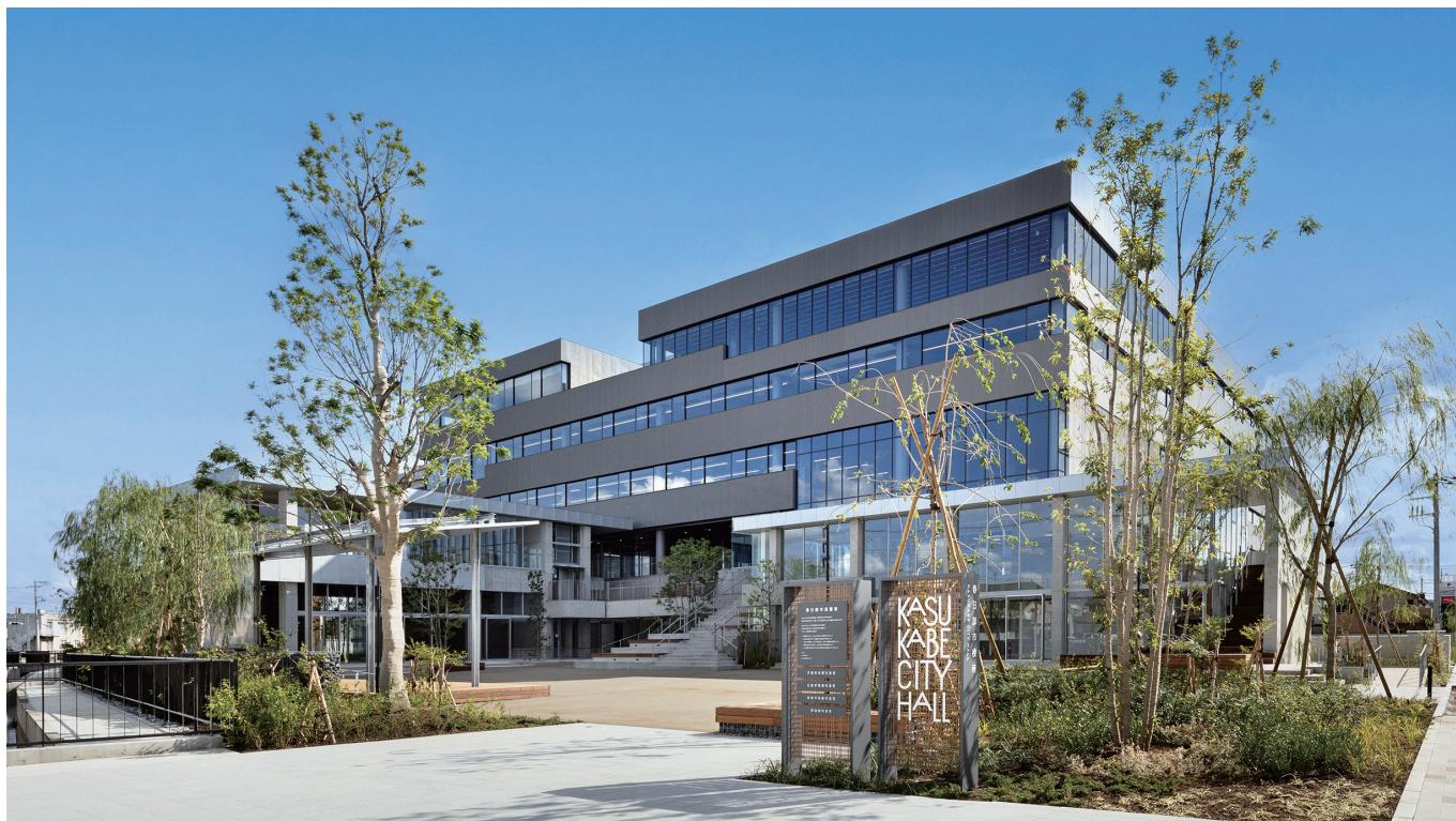
▲春日部市役所新庁舎。北西側まちなかひろば入口
