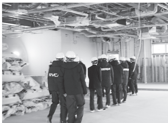
工事中の現場を見学する生徒達
