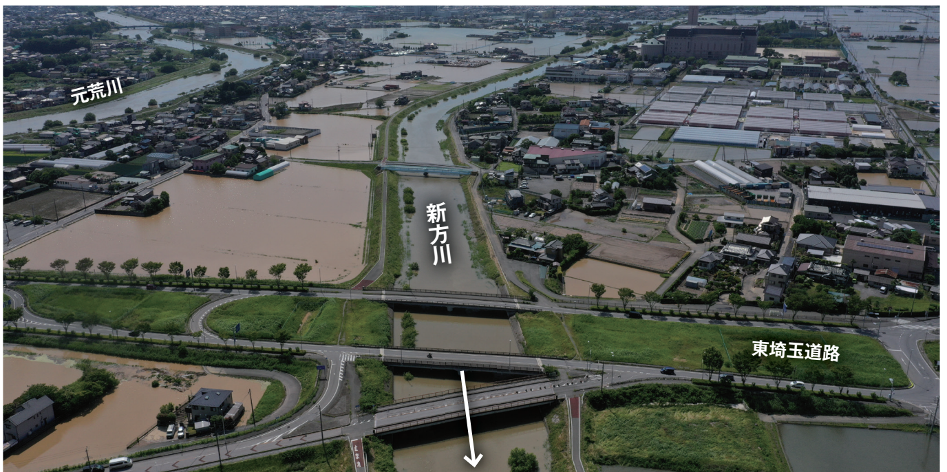
▲新方川浸水状況
